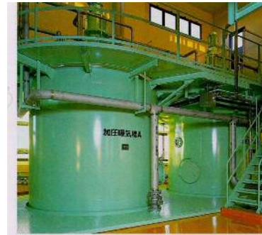
写真1 加圧曝気槽設置例
