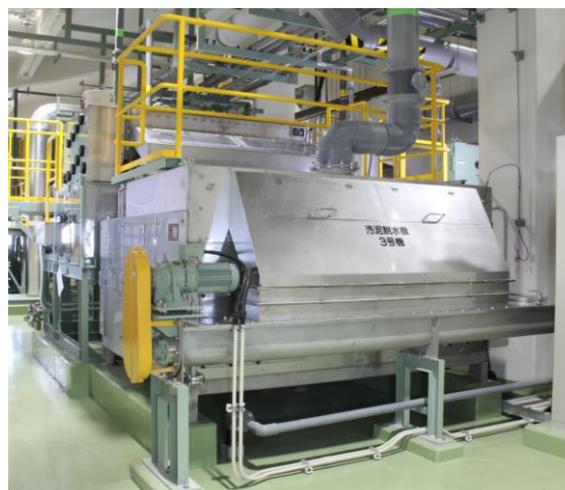
図-22 電気浸透式汚泥脱水機の外観
