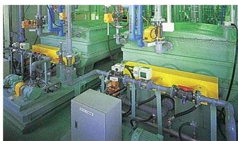
図-13 膜分離装置(回転平膜)
