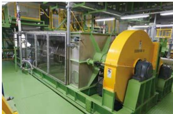
図-24 汚泥脱水設備
