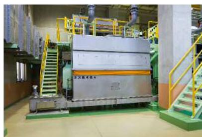
写真 13 電気浸透式脱水機（三原市）
