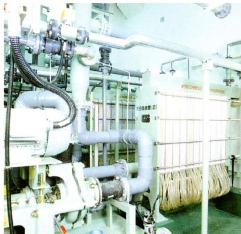
図7 循環吸引式の膜モジュール
