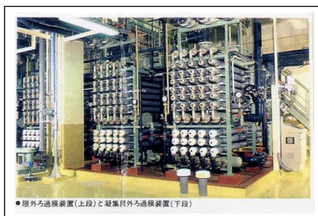
写真-1 限外ろ過膜の設置事例
