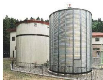
写真 5 BIMA 発酵槽(左)とガスホルダ
