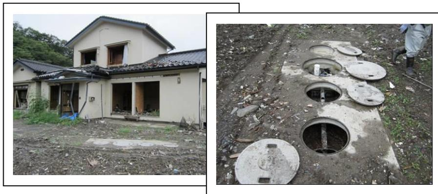
写真-5 廃屋の浄化槽
