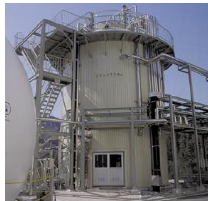
写真 4.3-3 メタン発酵槽 (同組合) 5)
