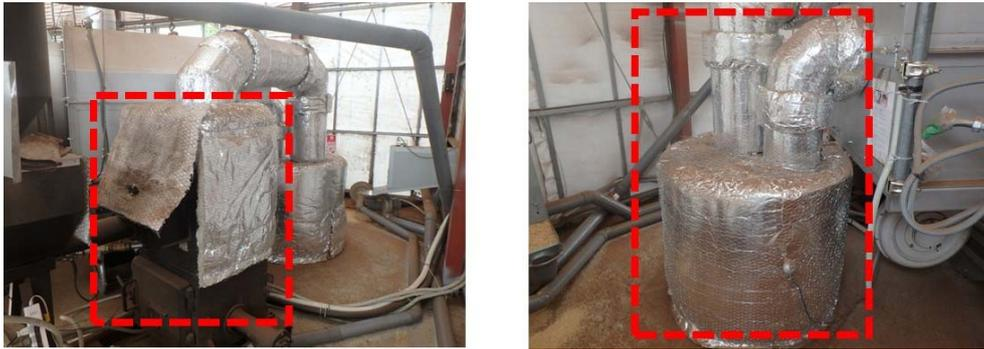
図 2-20 籾殻燃焼器（左：燃焼部、右：熱風供給部）
