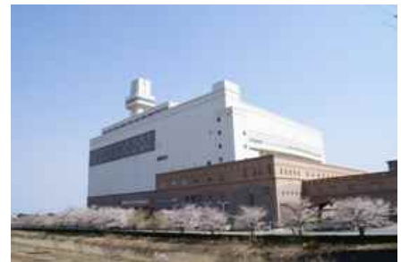
富山地区広域圏クリーンセンター 全連続炉 270t/24h 発電能力 20,000kW
