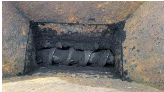
図 2.1.1-7 キャリブレーション開始前のスクリュコンベヤ写真
