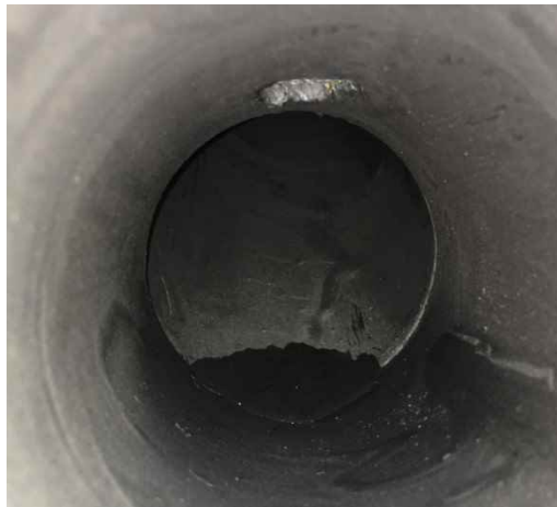
図 2.1.2-11 立ち上げ角度 30^\circ の条件における立ち上げ部の滞留物
