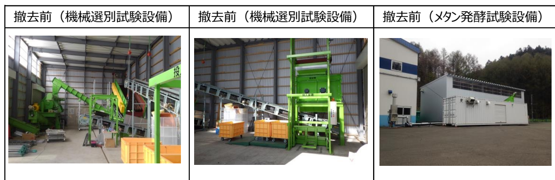
図 2.10-1 撤去工事前風景
