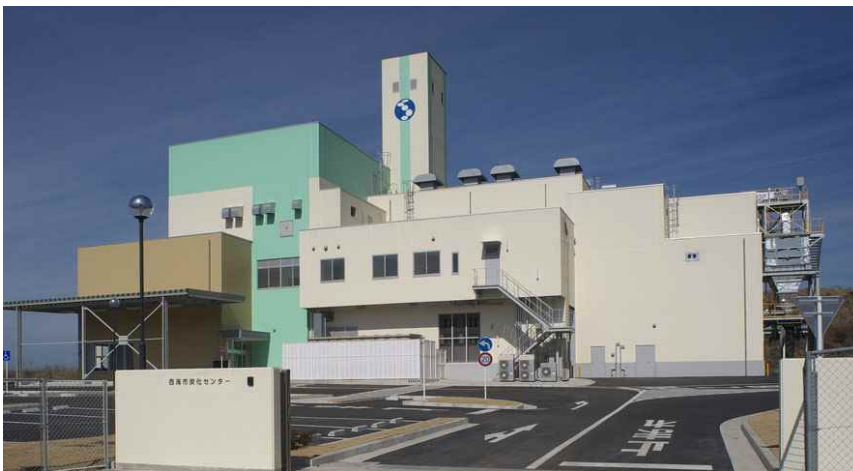
施設外観 (出所：㈱グリーンコール西海HP)
