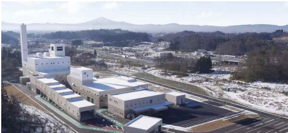
施設全景（出所：㈱よこてEサービスHP）
