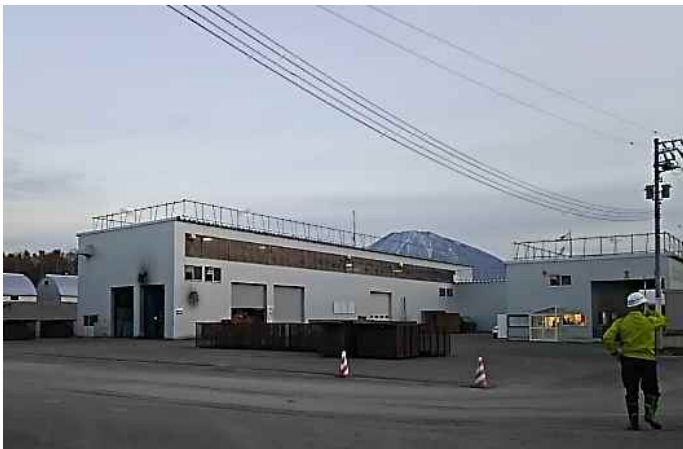
RDF化施設全景
