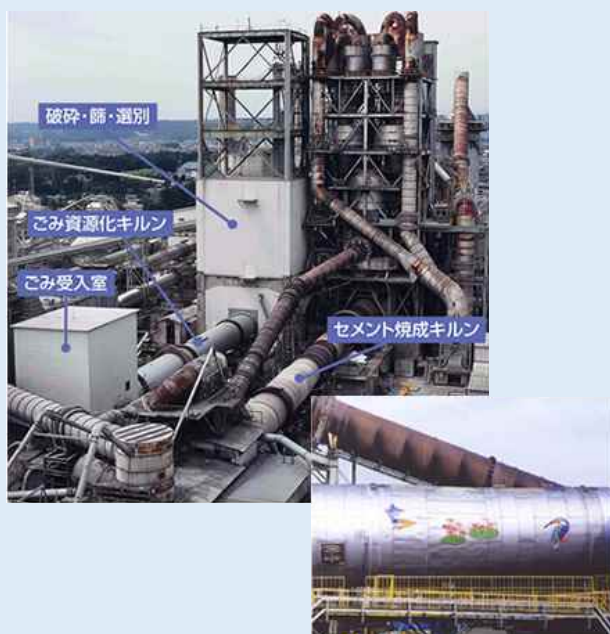
処理施設外観及びごみ資源化キルン （出所：太平洋セメント(株)HP）
