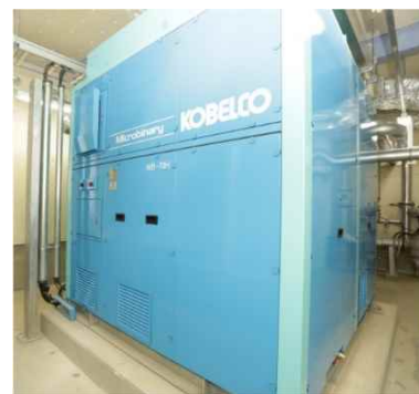
バイナリー発電設備
