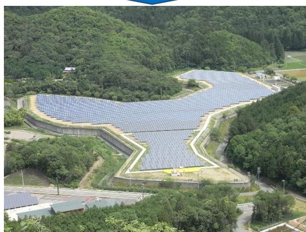
写真 4-1 ドリームソーラーぎふ太陽光発電所
