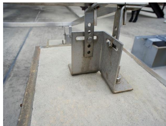
写真 5-2 高さを微調整可能な治具を設置 出典：堺太陽光発電所
