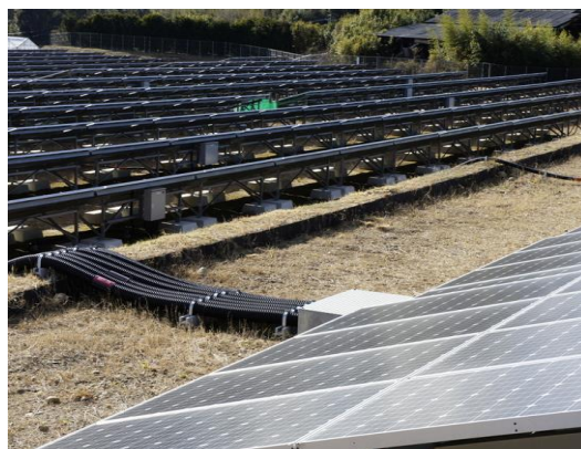
写真 5-10 処分場雑壇ごとに土堰堤を設置 出典：浜松・浜名湖太陽光発電所
