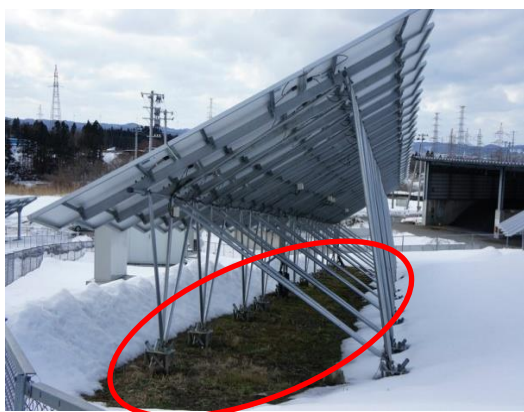
写真 5-9 太陽光パネル下に草丈の低い植物を植栽 出典：秋田市メガソーラー発電所
