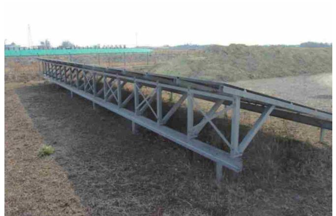
設備荷重は20kN/m<sup>2</sup>以下とし、設置に伴う荷重増加による処分場への影響を軽減
