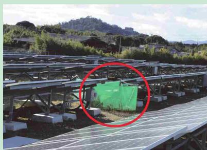
ガス抜き管を避けてパネルを設置し作業スペースを確保
