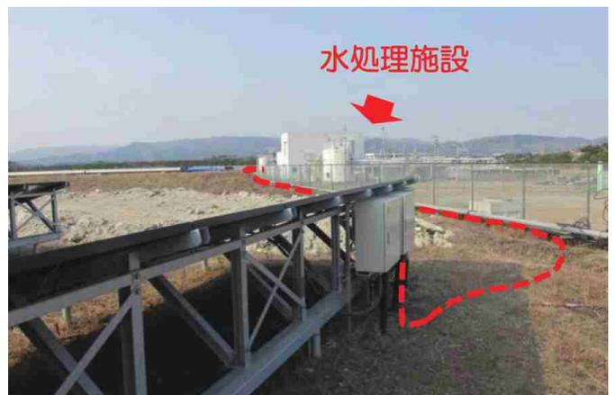
地下埋設されたケーブルにより発電した電気を水処理施設に送電
