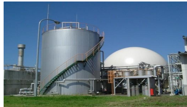
湿式メタン発酵槽（40t/d・発酵槽2槽） （出所）富山県 ホームページ
