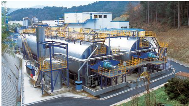
乾式メタン発酵（50t/d・発酵槽2槽） （出所）株式会社タクマ ホームページ
