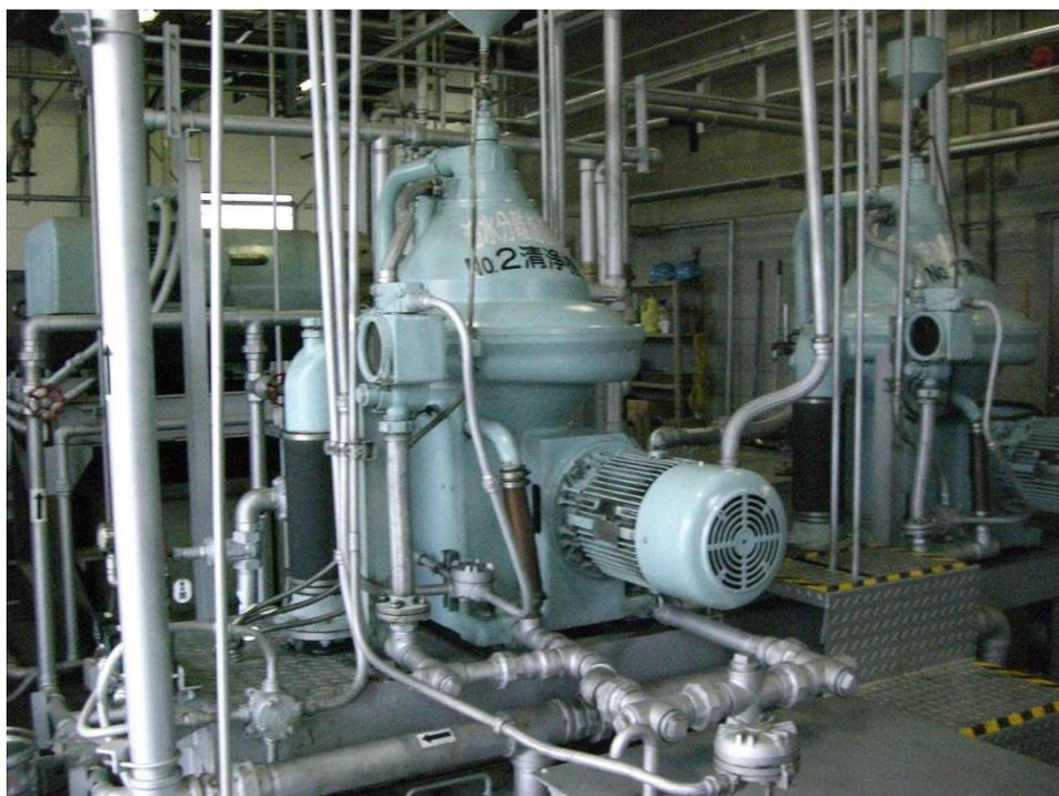
図2：廃油処理施設（遠心分離機）
