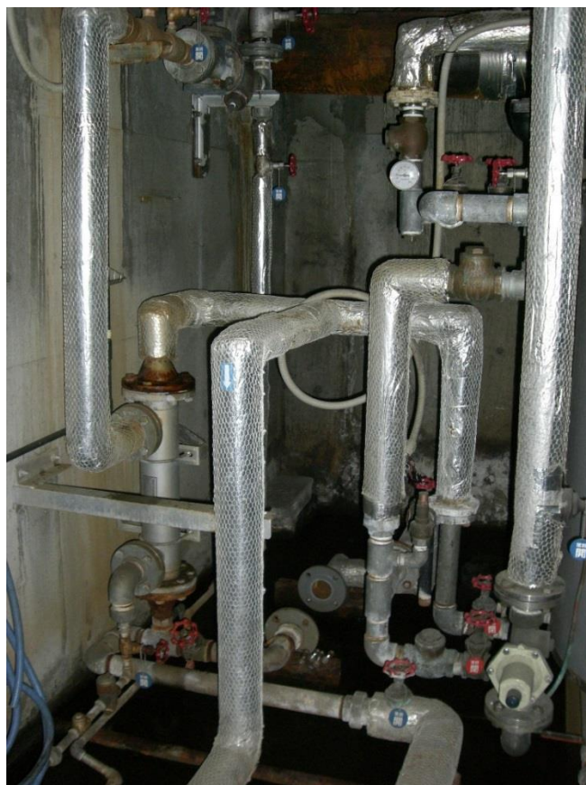
図 3 : 温泉施設ボイラー室 (熱交換器設置後)
