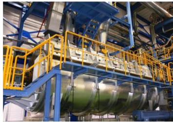
乾燥施設 (2007年完成、稼働開始)
