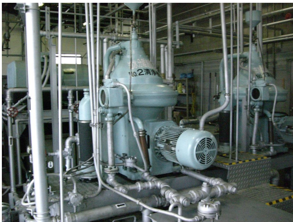
図2：廃油処理施設（遠心分離機）
