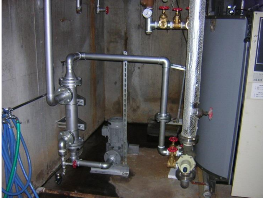
図4：温泉施設ボイラー室（熱交換器設置前）
