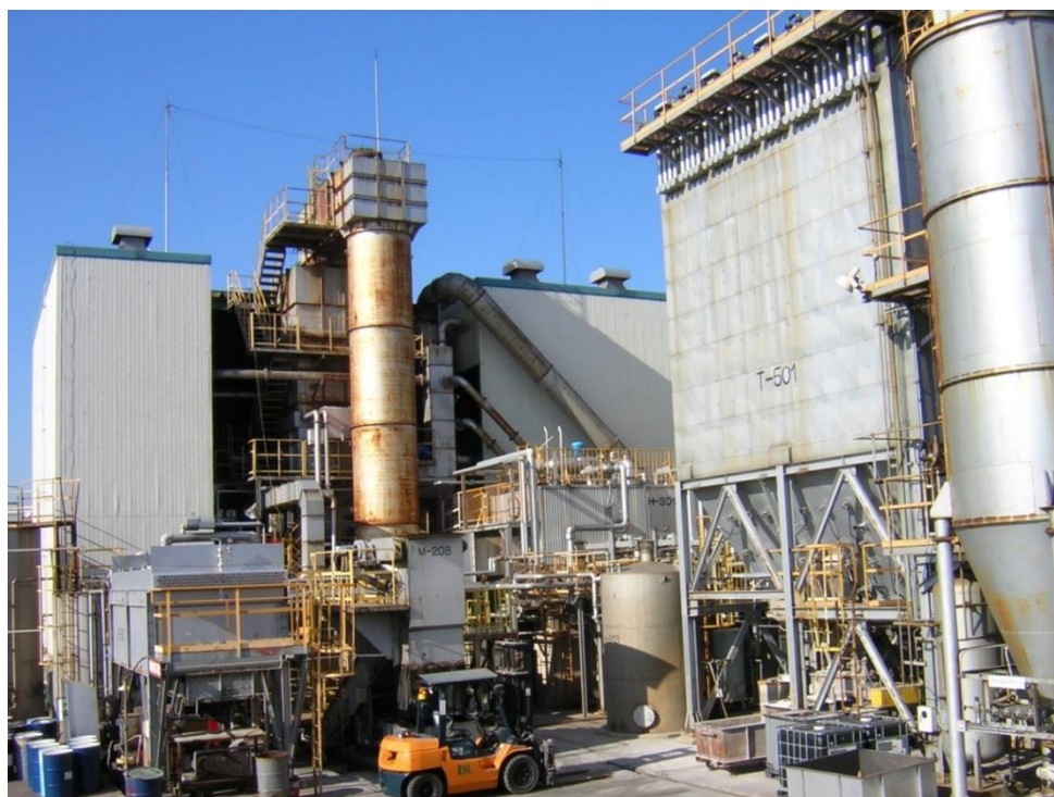
図 1 : KEC の廃棄物処理施設
