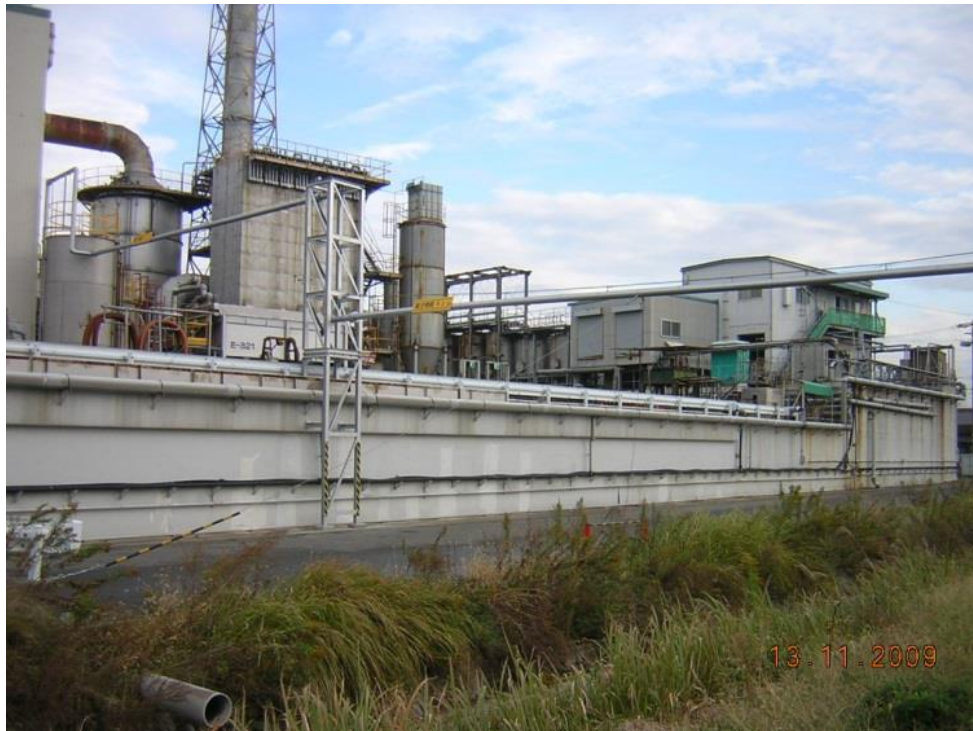
図 2 : KEC から温泉施設へ蒸気を供給する配管
