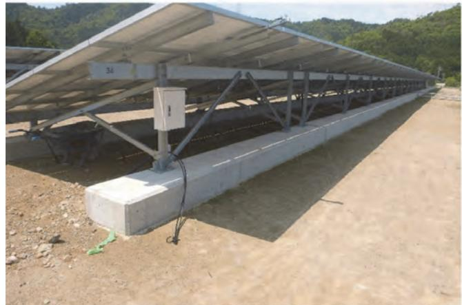
地下の廃棄物への影響と不等沈下に備えて連続式の基礎を採用
