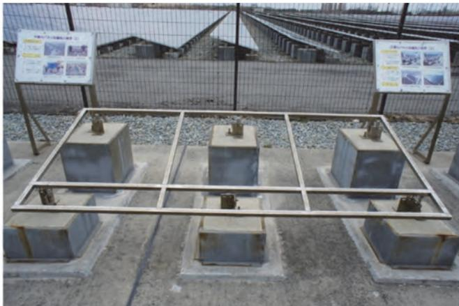
風荷重対策として基礎コンクリートにパネルを直接固定する方式を採用
