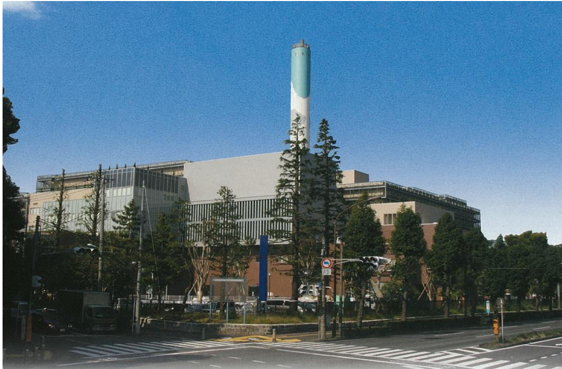
図 2.2-1 世田谷清掃工場 外観 東京二十三区清掃一部事務組合 世田谷清掃工場パンフレットより
