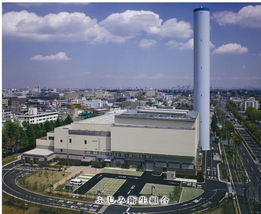
図 2.2-1 クリーンプラザふじみ 外観図 ふじみ衛生組合パンフレットより
