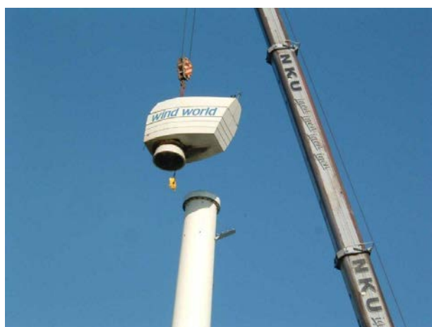
（ナセルの取外し）
