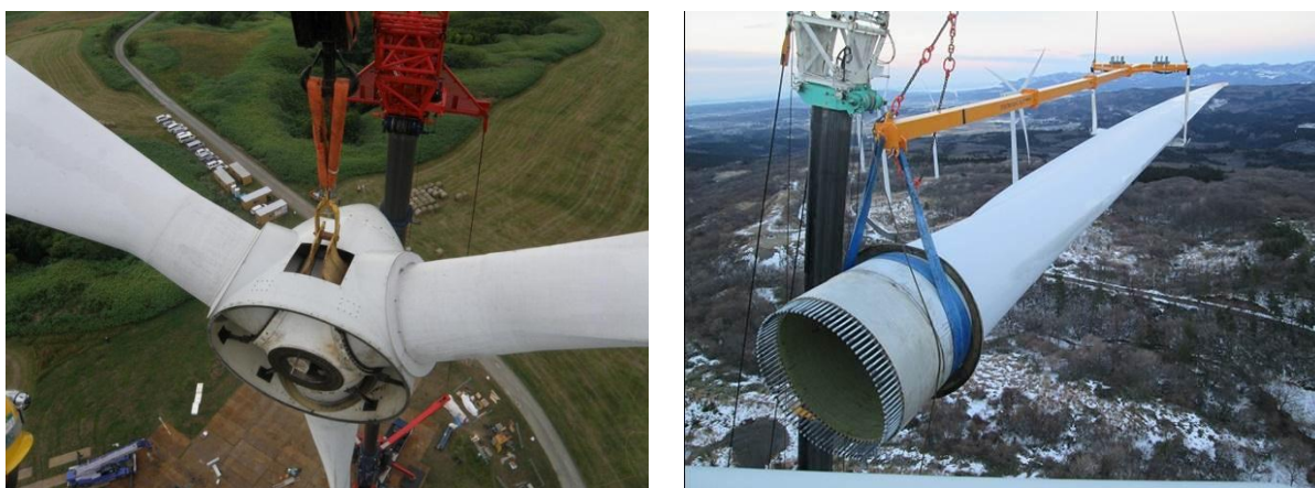
図 5-10 専用治具を用いたローター・ブレードの吊り上げ作業の様子
