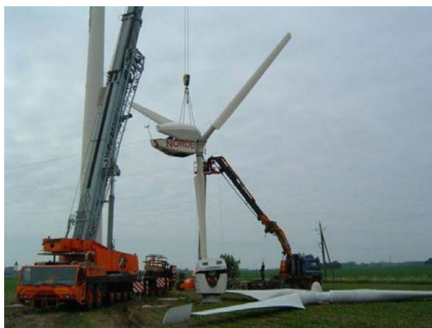
（ローター・ナセルの解体）
