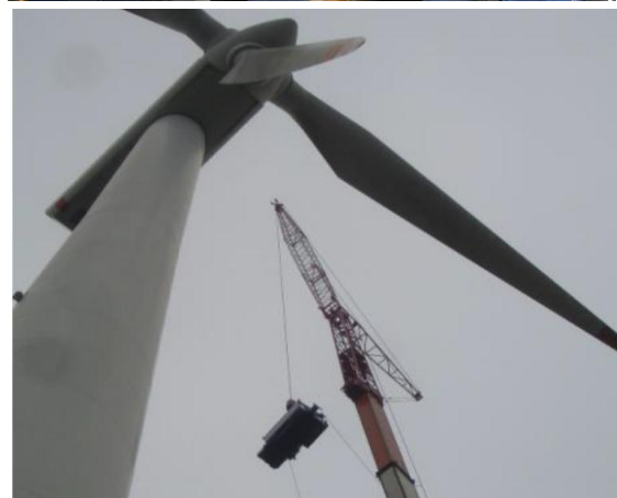
(増速機、発電機の取外し・搬入)
