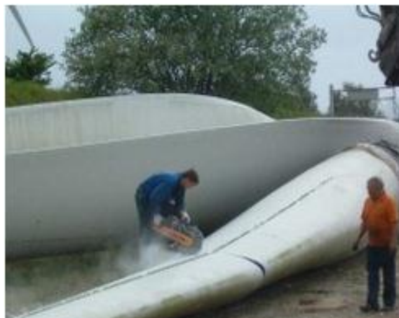
図 5-17 ブレード解体作業の様子
