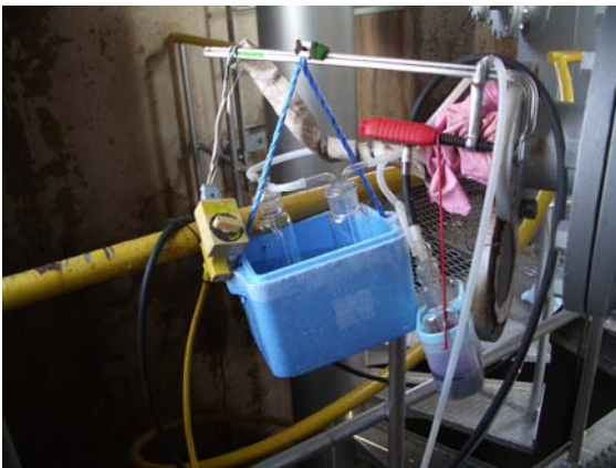
排ガス測定部
