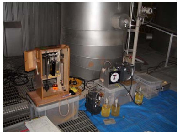
排ガス機材部
