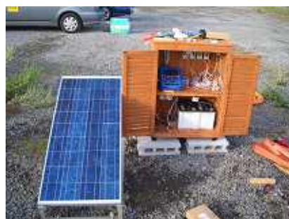
参考図6.7 観測小屋と太陽電池パネル
