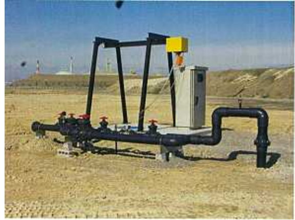
ポンプピット設置状況
