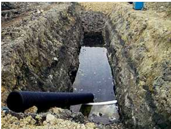
暗渠埋設工事中
