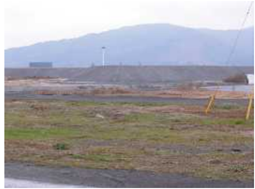
載荷盛土状況（2号地）
