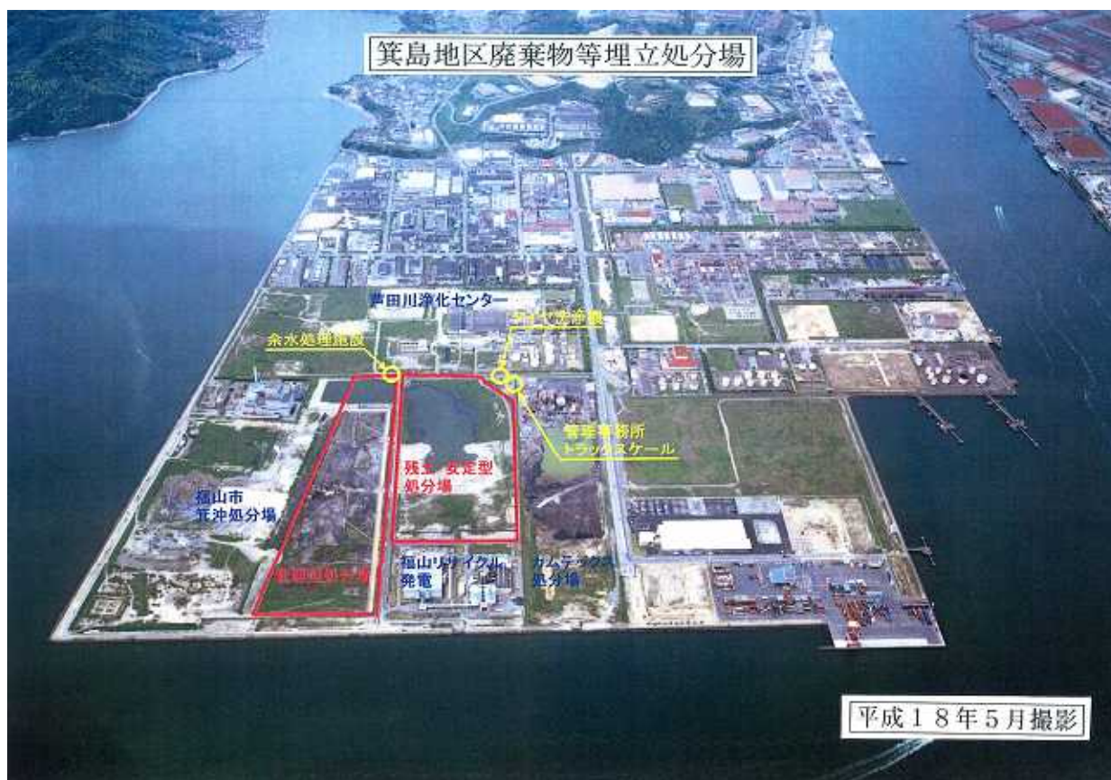
図 5.4.3.1 処分場航空写真
