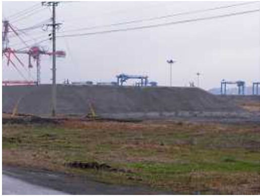
載荷盛土状況（2号地）
