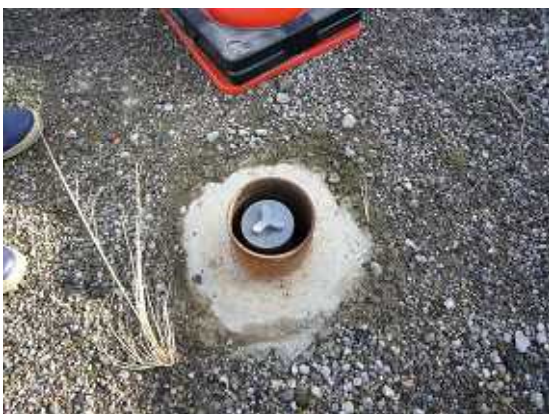
埋立ガス観測孔
