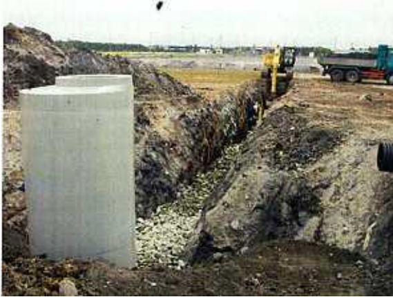
掘削・マンホール設置状況
