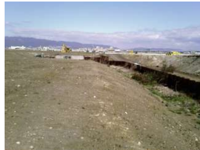
図 2.2.8 内水ポンド直上流の遮水工
