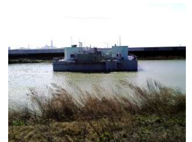
図 2.2.13 内水ポンド水面上の水処理施設
