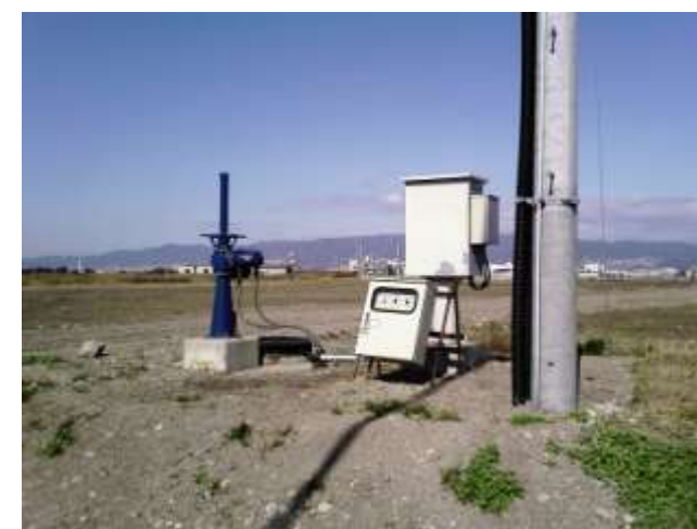
図 2.2.12 保有水汲み上げポンプ装備
