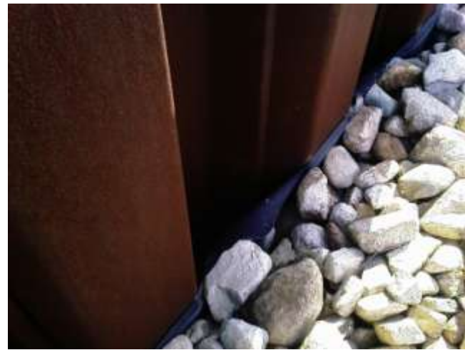
図 2.2.7 同左接写（矢板+遮水シート）
