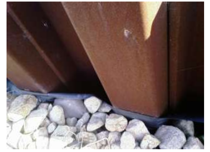
図 2.2.9 同左接写（矢板+遮水シート）
