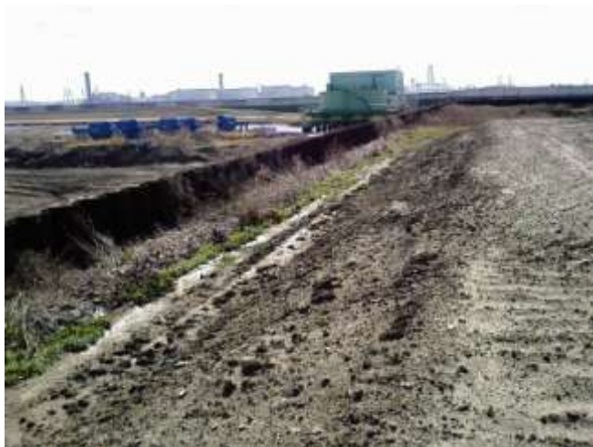
図 2.2.6 安定型処分場との区画境界の遮水工
