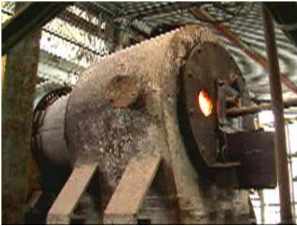
写真 2.2-6 テストプラント窯前
