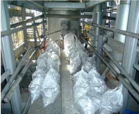
処理対象物 （ケース1・アスベスト含有スレート）
