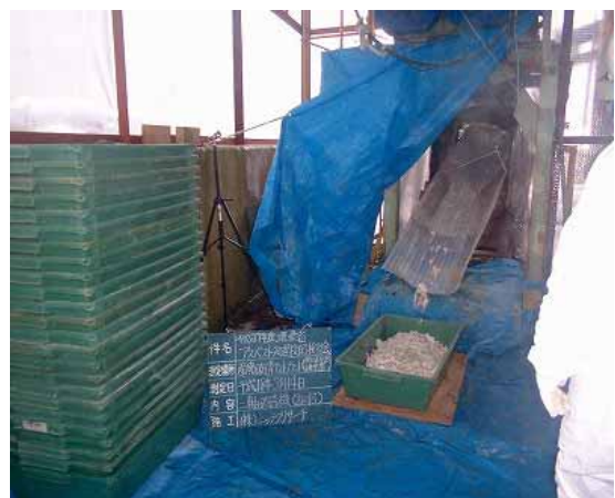
二軸破砕機：サンプリング状況 ( ろ過速度1m/min・発じん状況調査・排出室 )
