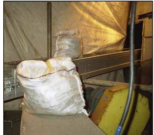
アスベスト含有物投入状況
