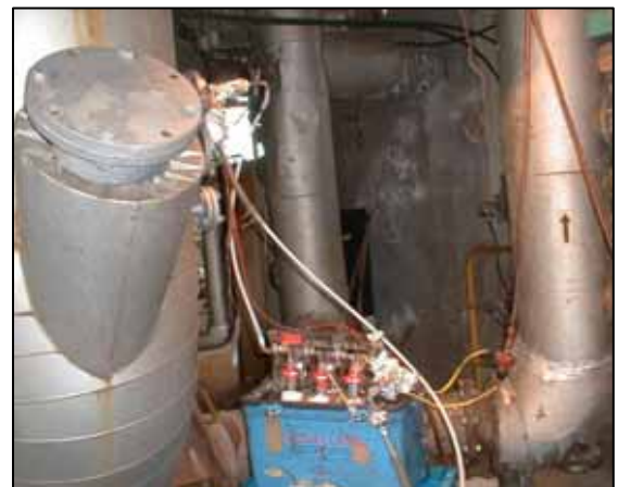
サンプリング状況 (BF入口燃焼排ガス)
