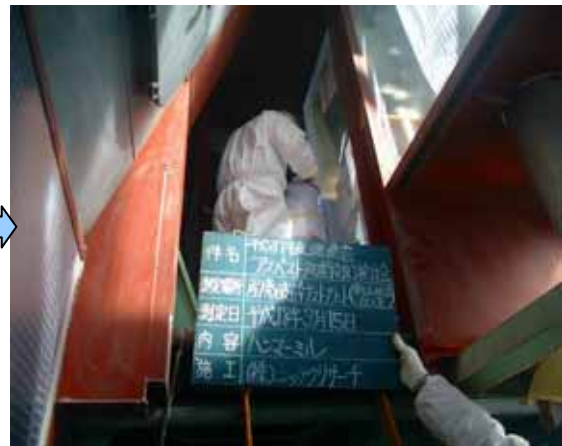
第2回：ハンマーミル（投入室）
