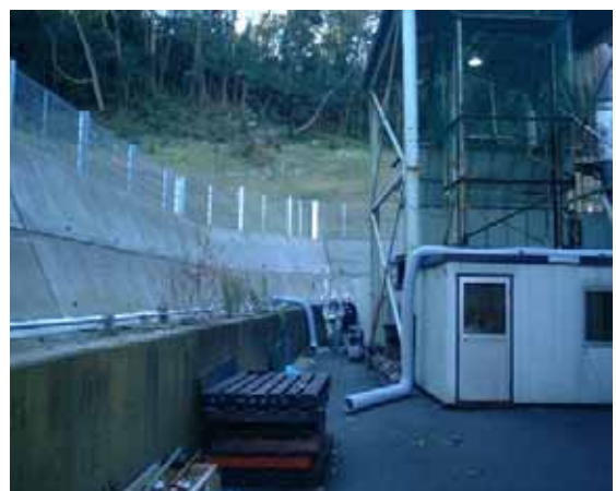
二軸破砕機 : サンプルング状況 ( ケース 1 ・敷地境界風下 )
