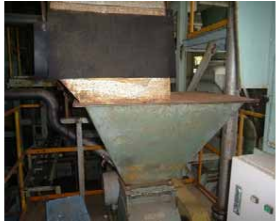
ハンマーミル ( 投入口周辺 )
