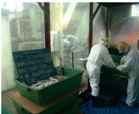
二軸破砕機：サンプリング状況 ( ろ過速度3m/min・発じん状況調査・投入室 )
