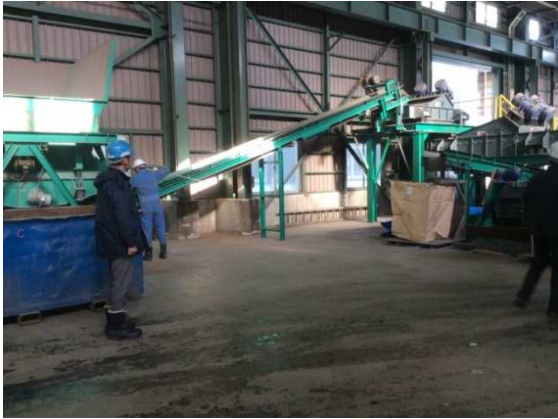
図 1-33 破碎後ホッパーへ投入
