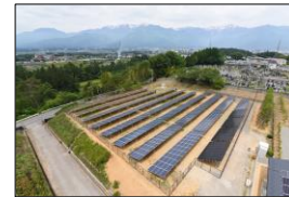
リユース品を使用した発電所
