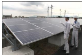
太陽発電設備の検査の様子
