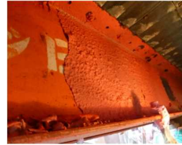
写真 橋梁塗膜除去工事の状況
