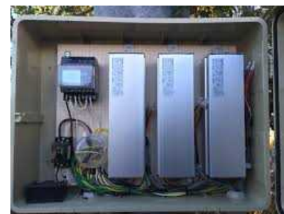
安定器BOXに収納された安定器
