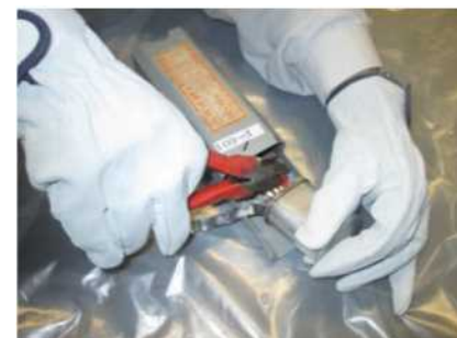
PCB含有のコンデンサ部分の取り外し作業
