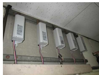
工場等の壁際に設置されている例
