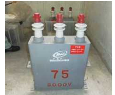
電力用コンデンサー
