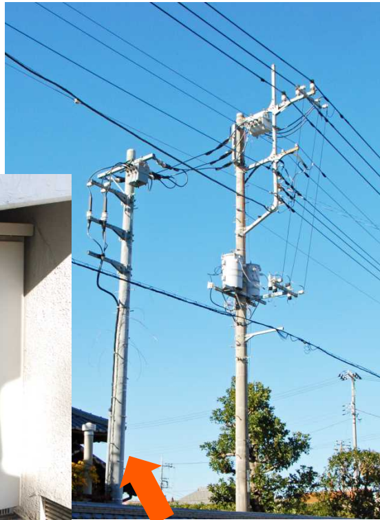
自家用架空引込柱 (6,600ボルト受電)
