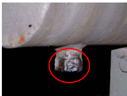
放熱器排油栓からの滲み漏れ
