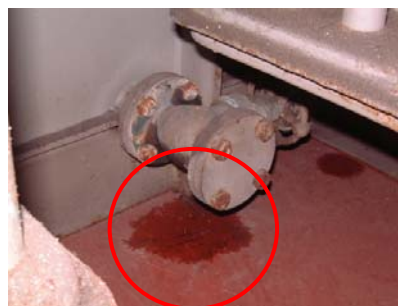
ガスケットからの滲み漏れ
