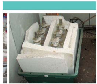
地震等による転倒防止例 (パッキング材の充てん)
