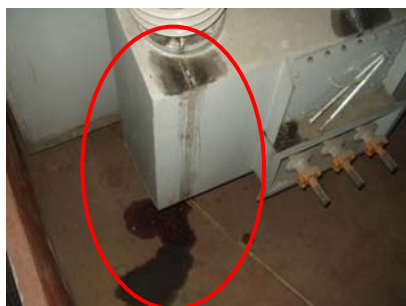
ブッシングからの滲み漏れ
