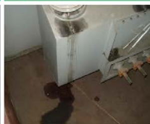
にじみ漏れの例（悪い例）
