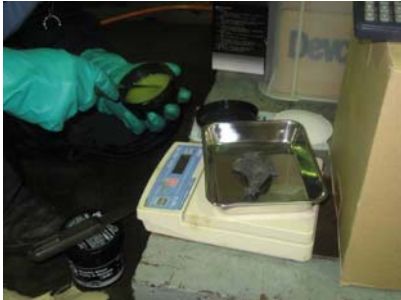
③ 硬化剤の取り出し
