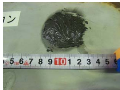
（トランス・パネル面部の例）
