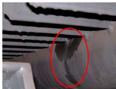
放熱器溶接部からの滲み漏れ
