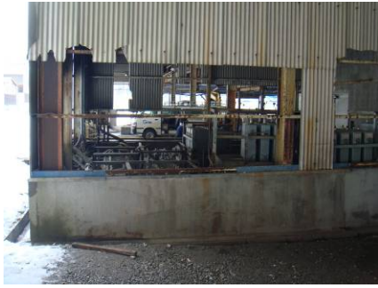
PCB 廃棄物保管庫（工場外側から）
