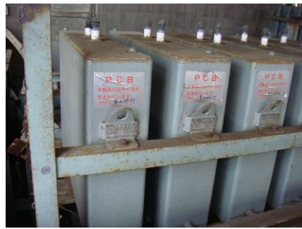
アングル枠に固定した様子
