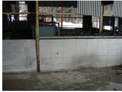
PCB 廃棄物保管庫（工場内側から）
