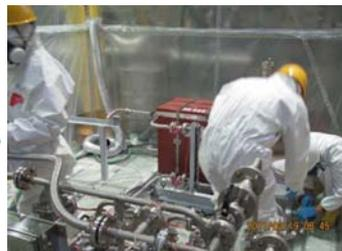
設備改造等に向けて、容器内洗浄実証試験を実施。
