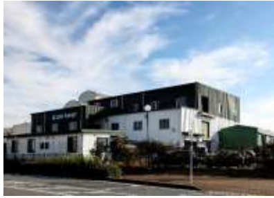
図 5-2 再生利用等施設の外觀
