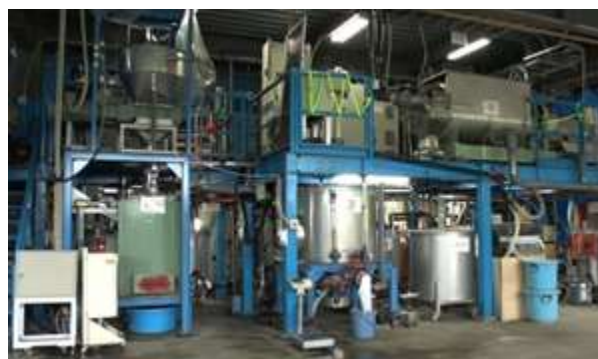
図 5-7 再生利用等設備の概観（実証施設）
