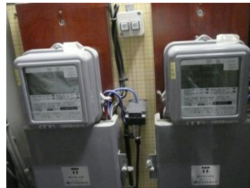
写真2 買電用と売電用電力量計
