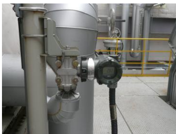
写真6 主蒸気ライン圧力計
