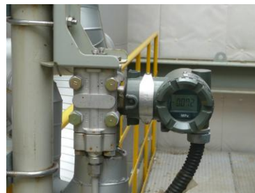
写真7 復水器入口蒸気圧力計
