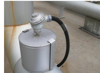
写真5 温水供給温度計
