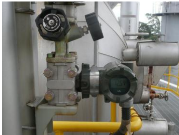
写真3 主蒸気ライン流量計
