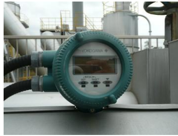
写真4 温水供給流量計
