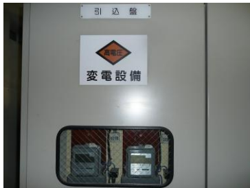
写真1 電力量計引込盤
