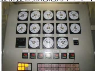
写真8 発電機監視盤
