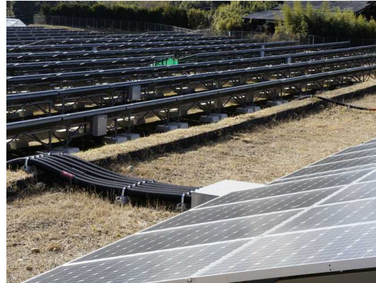
写真 5-10 処分場雑壇ごとに土堰堤を設置 出典：浜松・浜名湖太陽光発電所
