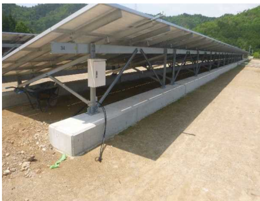
写真 5-1 連続基礎を用いた不等沈下対策 出典：ドリームソーラーぎふ 太陽光発電所
