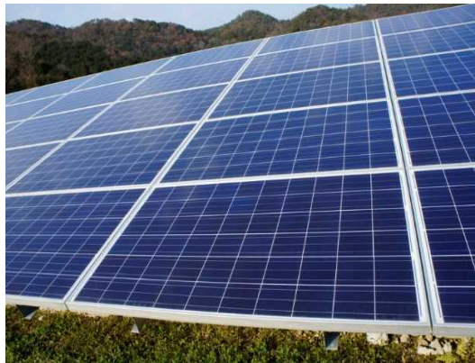
写真 5-8 光害等に対応した太陽光パネルを採用
