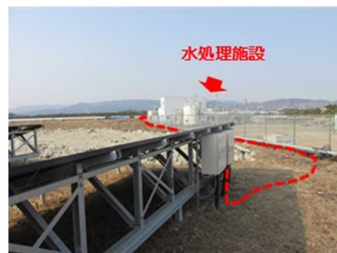
コラム写真 5-1 太陽光発電設備と水処理施設
