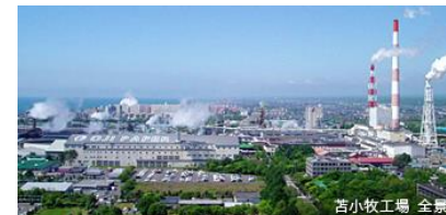
苦小牧工場 パルプ生産能力:2,170 t/日
