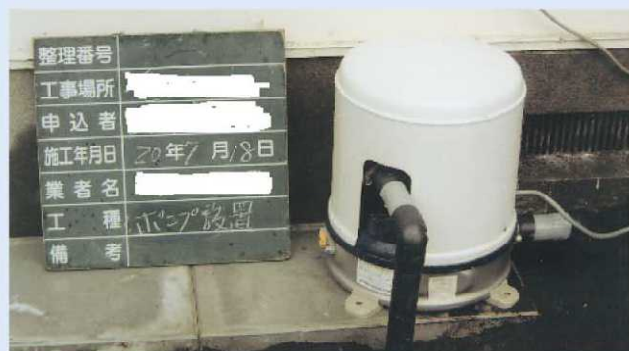
6.水中ポンプ設置
