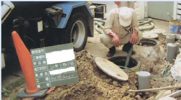
1.浄化槽汲取り
