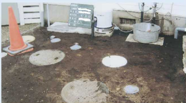
7.雨水貯留槽 完成
