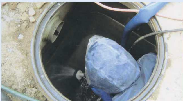
3.浄化槽内清掃
