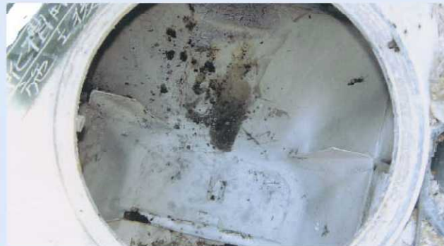
2.浄化槽解体施工
