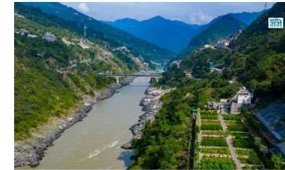
Devprayag 1.40 MLD NJK (STP)
