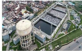
Moradabad 58 MLD NJK (STP)
