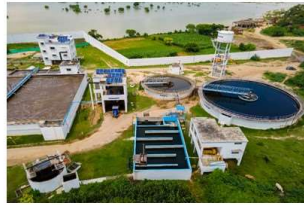
Kodra , Prayagraj 25 MLD NJK (STP)
