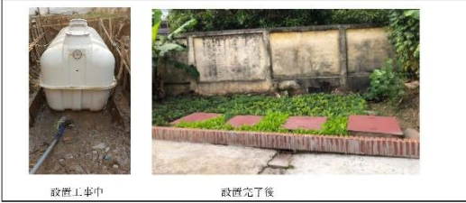
図 52 浄化槽の設置状況
