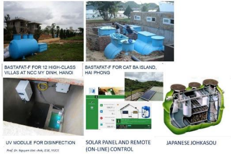
図 7 機械化されたオンサイトサニテーションシステム
