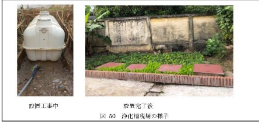
図 50 浄化槽現場の様子
