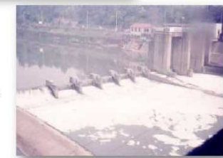
Chofu Weir, Sông Tama (Tokyo) '1970
