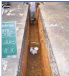
発生土の管きょ基礎への利用(半田市)
