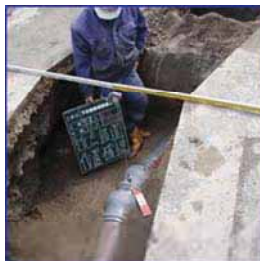
道路線形に合わせた施工 (岡崎市)
