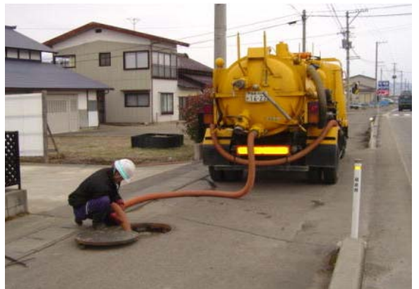
マンホールに滞水した汚水をバキューム車でくみ取り応急対応を実施
