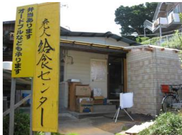
給食センター外観
