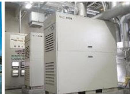
■事業概要：本事業では、汚泥の処理工程で発生するバイオガスを有効活用する為に、**バイオガス発電機の設置**及び排ガスを利用した**コージェネレーションシステムの構築**を実現。これにより**化石燃料使用量を大幅に削減**させ、**CO2排出量を削減**し「リデュース」を積極的に実施する。
