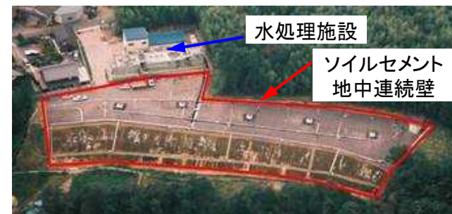
<対策工施工後の状況>
