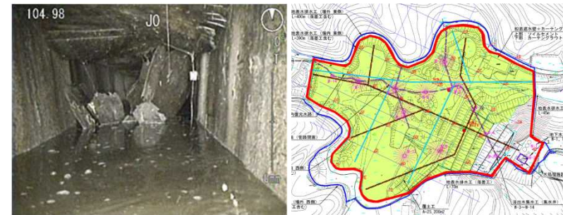
崩落した地下水路
