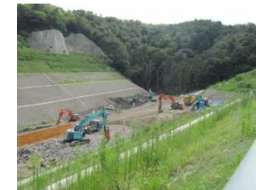
掘削作業状況
