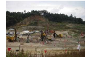
注水消火作業状況
