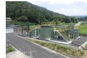
浸出汚濁水処理施設
