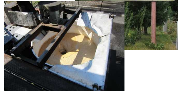
攪拌機械による作業
