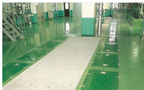
写真 4.4-2 覆蓋式ばっ気槽上部 2)
