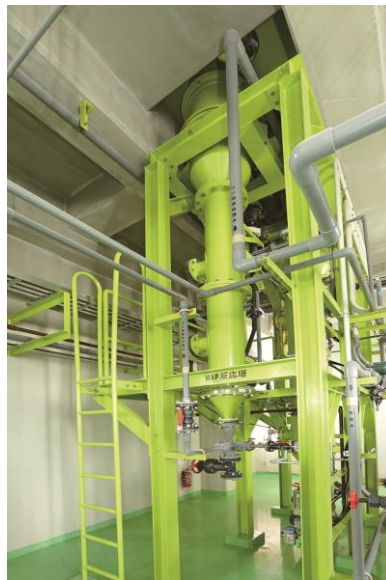
写真 4.3-16 リン回収リアクタ 11)
