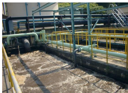
写真 4.4-1 開放型ばっ気槽 1)
