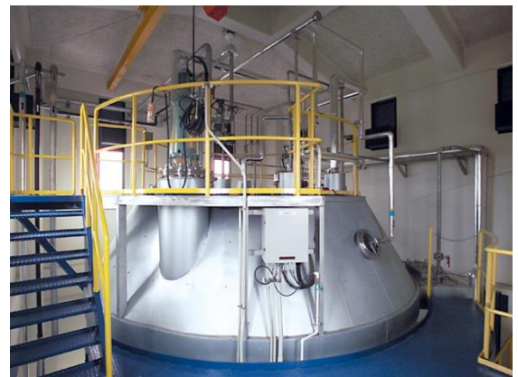
写真 4.3-4 メタン発酵を備えた汚泥再生処理センター（新潟県舞平清掃センター） 写真 4.3-5 メタン発酵槽 上部 6)
