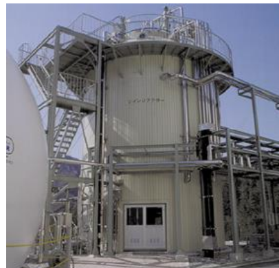
写真 4.3-3 メタン発酵槽 (同組合) 5)
