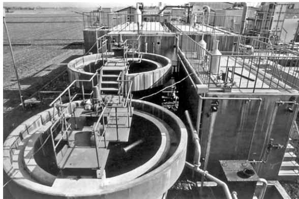
写真3.2-1 埼玉県加須市に建設した中間分離法の実証プラント 5)
