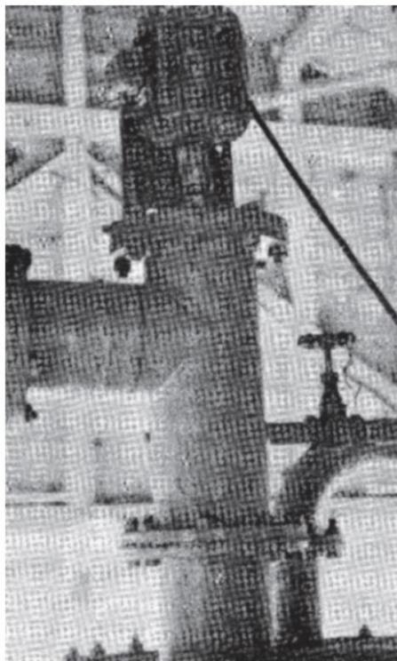
図 2.4-5 空中散布型曝気装置（アトマイザ） 4)
