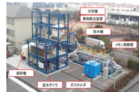
生ごみメタン発酵の実証プラント
